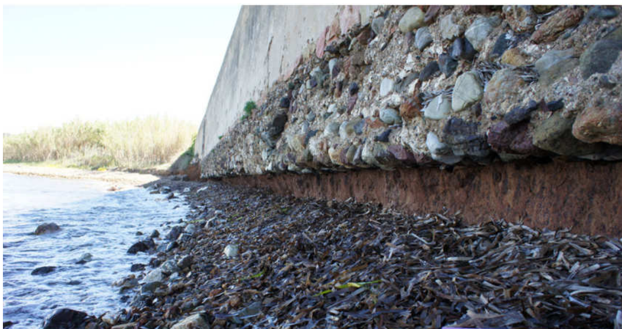
Foto n. 2.7 – Schiopparello Est: dettaglio del processo di distruzione del muro. L'intera fondazione è stata scoperta, e uno spessore quasi equivalente (qui è parzialmente coperto dalla Posidonia spiaggiata) di substrato argilloso compatto del terreno naturale di sottofondazione è stato asportato, con uno sgrottamento al di sotto della fondazione veramente pericoloso, e con gravi rischi di rovinosi crolli improvvisi in tempi ravvicinati. NB: quanto sopra e a pag. prec. è stato scritto nel 2016. Poco dopo il muro è crollato (v foto a pag. seguente), e nel 2017 è stato ricostruito, ma ora anche le parti adiacenti sopravvissute stanno per crollare.
