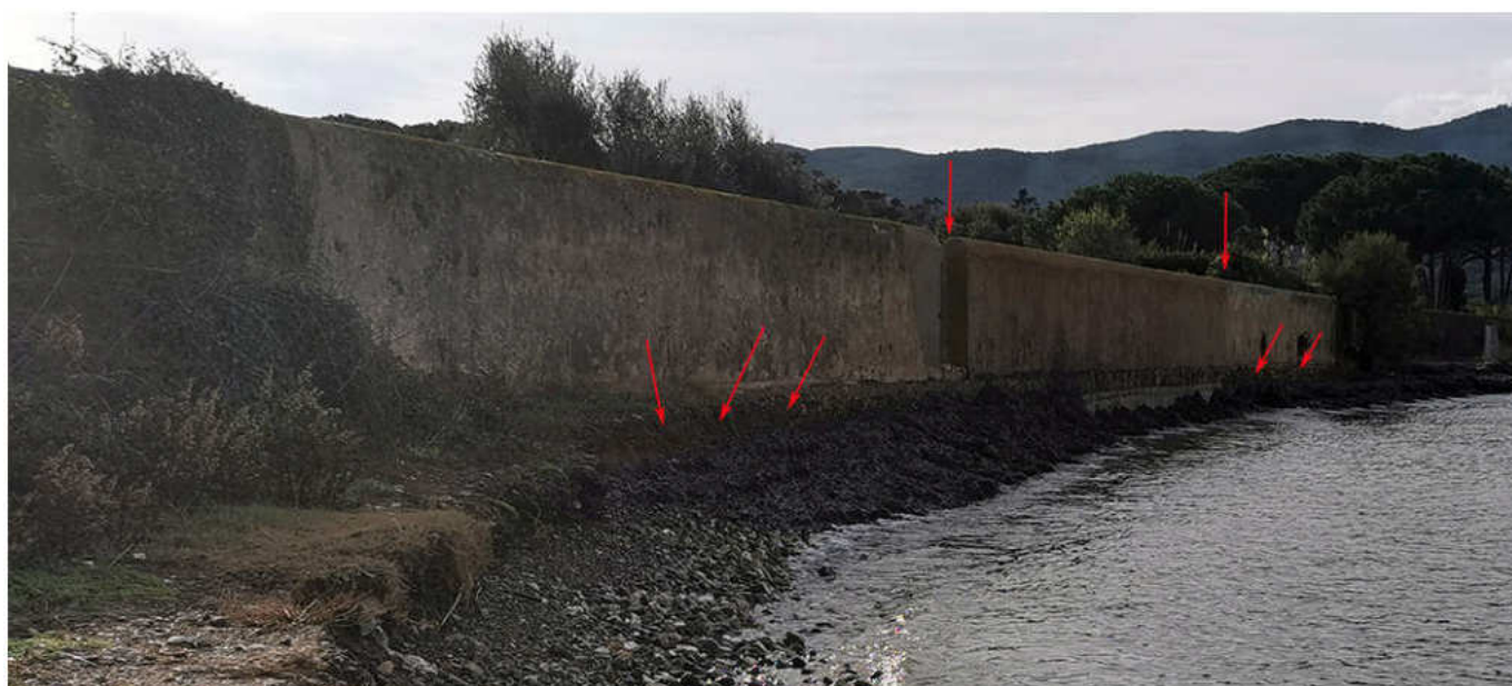
Foto 2.9 – L'immagine odierna del muro W della Fattoria Foresi. Le due frecce verticali delimitano la porzione crollata nel 2017 e subito ricostruita, la cui nuova base è a diretto a contatto col mare, ciò che aumenta ancora la riflessione energetica verso il largo e l'asporto dei sedimenti dalla riva. Le frecce inclinate mostrano i residui tratti di muro originale, che chiaramente non sono in condizioni di resistere ancora a lungo.
