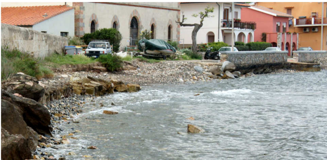
Foto n. 2.10 – La foce del fosso del Bucine (a destra), il muro del lungomare in fase di sgrottamento, la spiaggia residua lato Podere San Marco, i massi di protezione. NB: quanto sopra è stato scritto nel 2016. Nel 2018 il Comune, con un intervento di somma urgenza, ha posizionato una barriera radente in massi naturali a protezione del lungomare a rischio.
