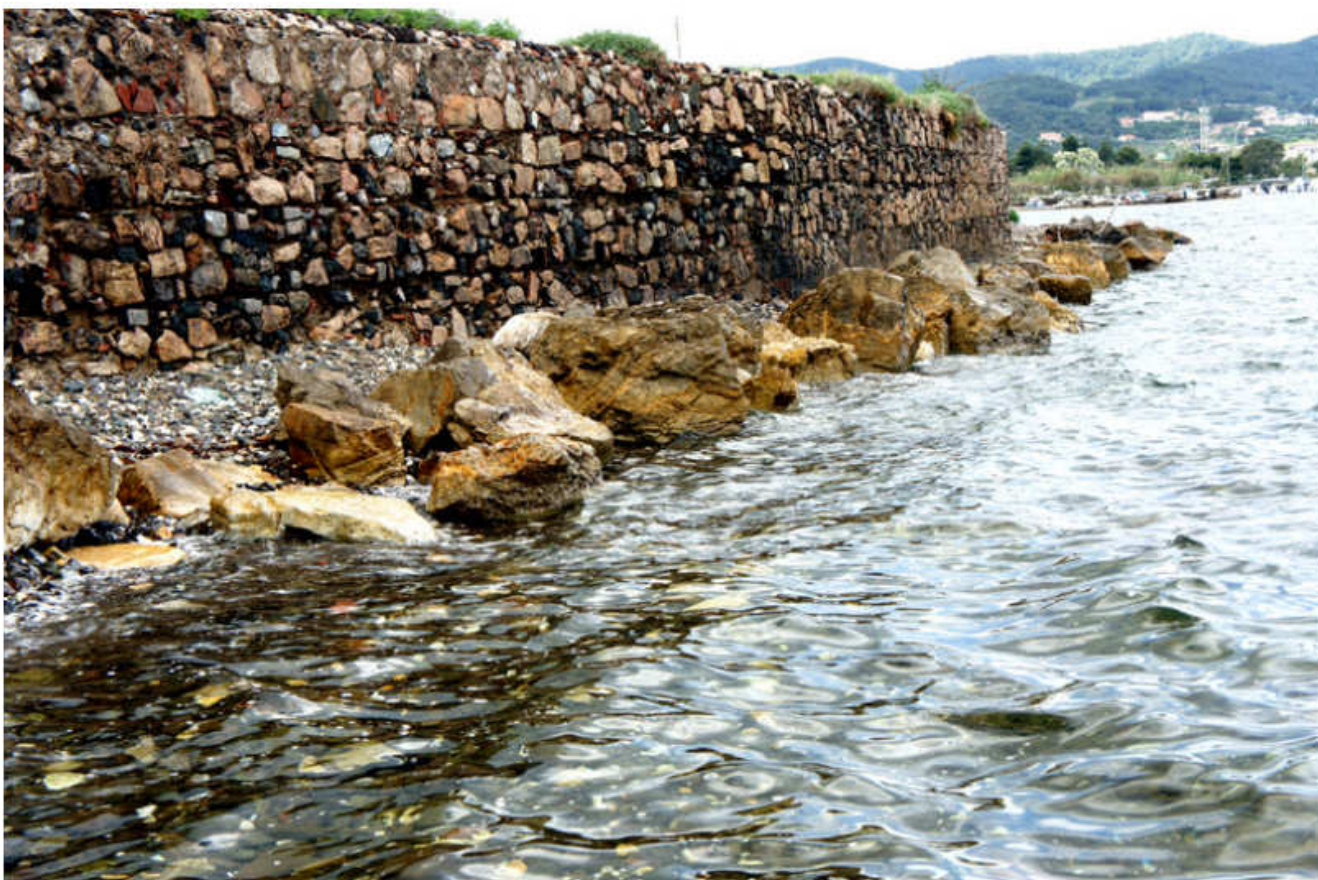
Foto n. 2.11 – Il muraglione di protezione e contenimento della Tenuta San Marco, soggetto all'aggressione marina. Evidenti i segni del degrado, nonostante i massi addossati alla riva.
