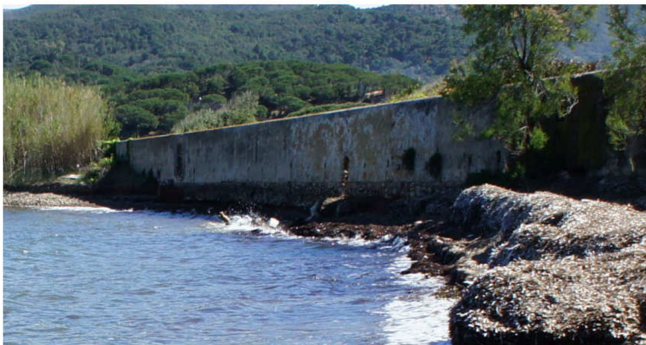
Foto n. 2.6 – Schiopparello Est: il muraglione di protezione del podere adiacente all'Hotel Fabricia in via di demolizione ad opera del mare. A destra il tamericio che ancora resiste, alla quota originaria di circa 1,80 m sul l.m. Il resto del terreno, a sinistra, è da tempo scomparso.
