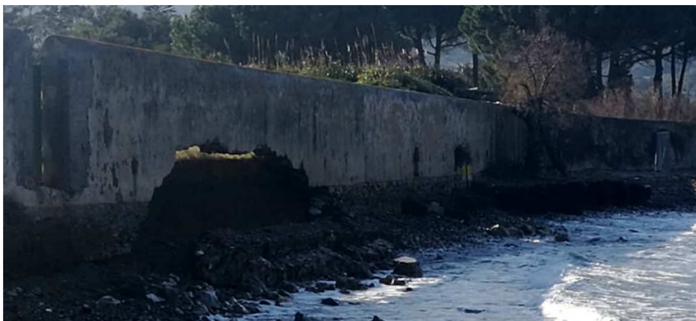
Foto n. 2.8 – Il crollo iniziale del muro di pag. precedente, seguito dopo pochi giorni dal collasso generalizzato dell'intera porzione. Fortunatamente nessuno transitava su questo tratto di spiaggia in entrambe le ricorrenze.
