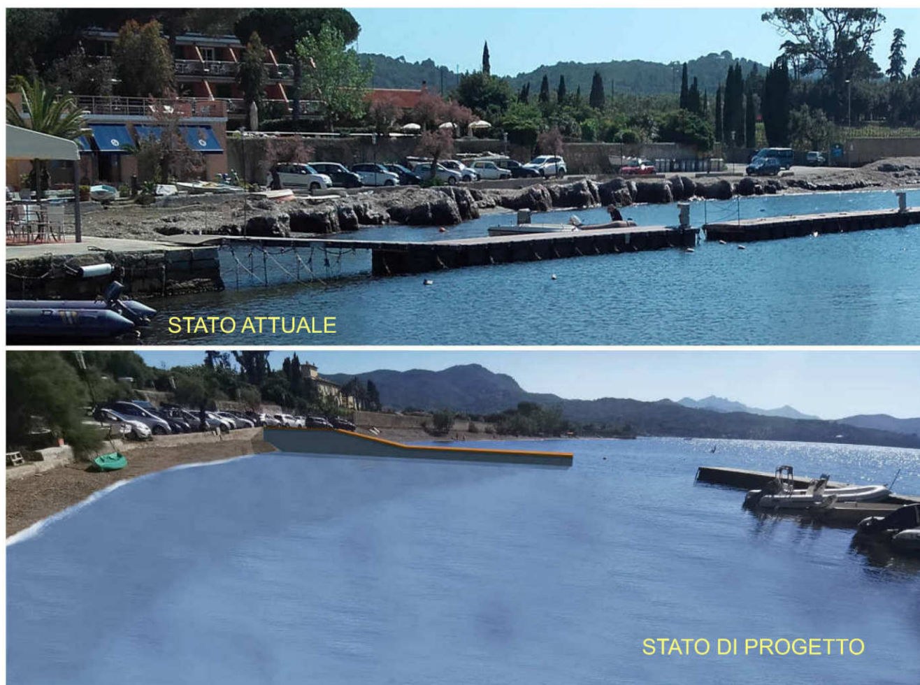
Fig. 3.2 – L’approdo di Magazzini: in alto lo stato attuale, in basso quello di progetto. L’altezza del moletto, limitata lato mare a 0,70 m, ne riduce l’impatto visivo, i costi e favorisce il suo uso ai fini nautici.
