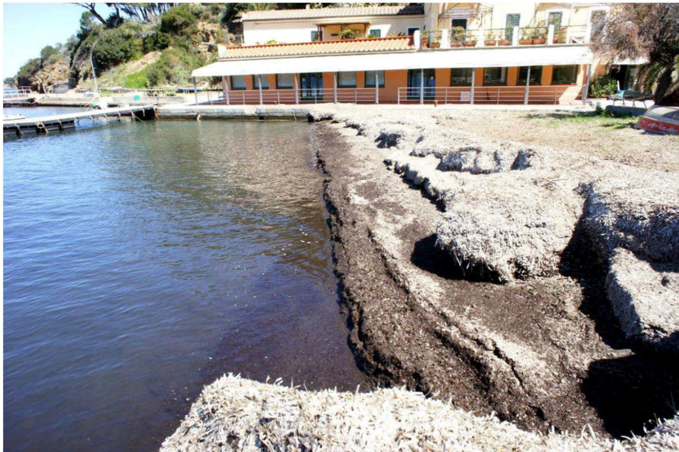
Foto n. 2.1 – L'approdo di Magazzini intasato di sedimenti di spiaggia e di Posidonia spiaggiata, sospinti lungo la spiaggia dalla corrente longshore W → E (v. Cap. 4)
