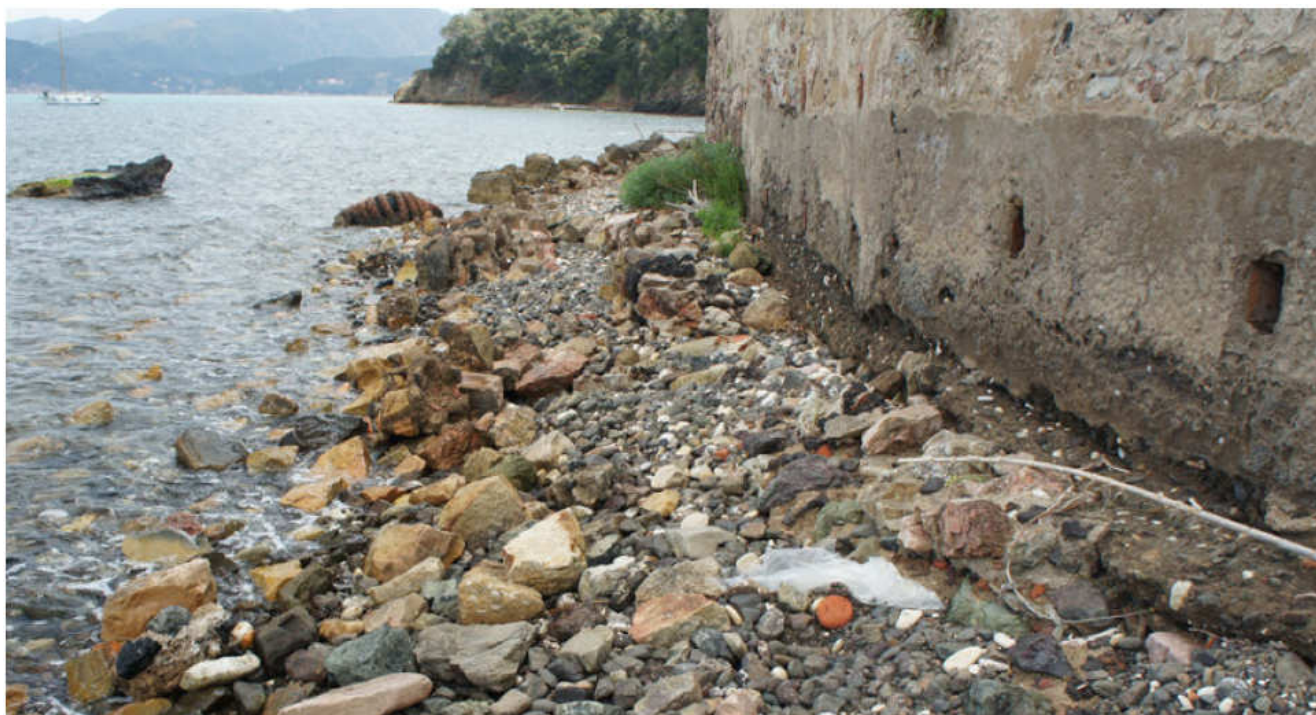
Foto n. 2.12 – Un'altra vista del muraglione. Sono evidenti i segni dello sgrottamento.
